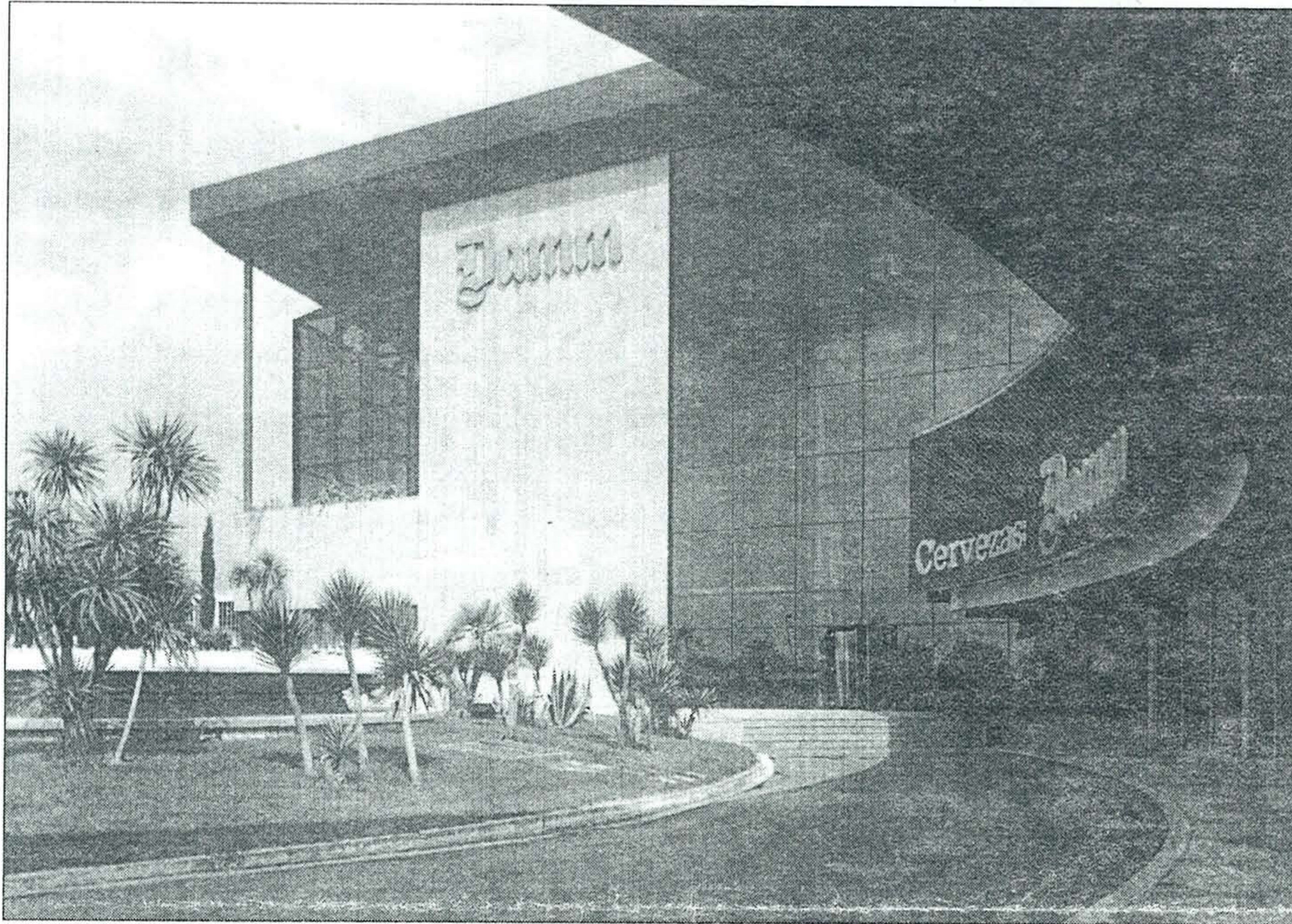
Vista exterior del edificio de cocción que ha diseñado la ingeniería terrassense.
